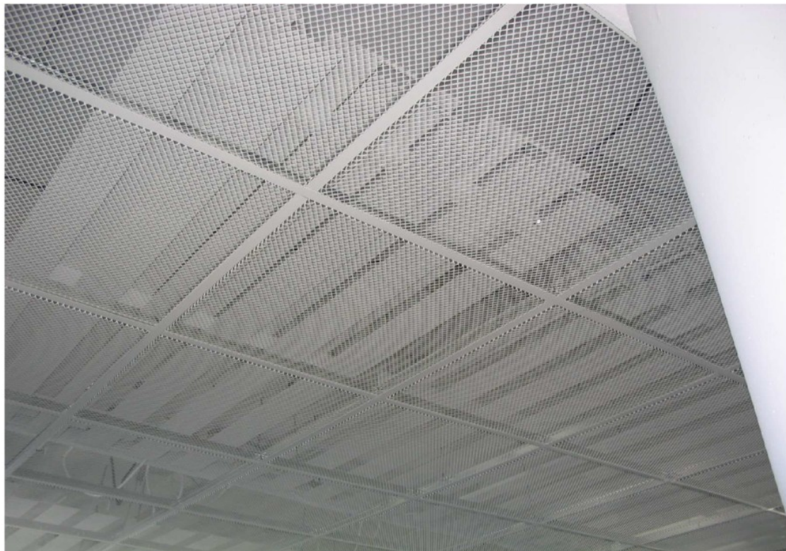
CON cool KHL monteret over et strækmetal loft
