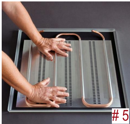
Fig | 7: WLT® Plug & Play er manuelt forbundet med tryk mod loftpanelet. Forbindelse mellem element og loftkassette er fremstillet af højt ydende tape med stærk vedhæftning.
